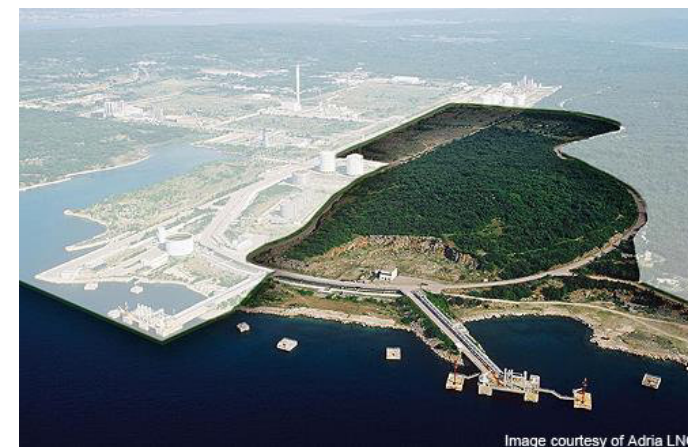
Prostor budućeg LNG terminala
