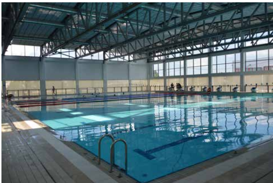
Bazen u Novom Jelkovcu - izvor: www.zagreb.hr
