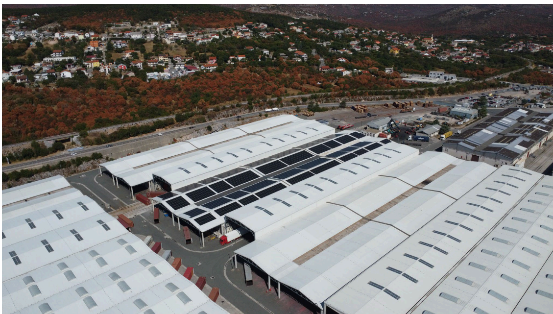
Terminal Škrlevo – pogled na skladišnu infrastrukturu i solarnu elektranu
