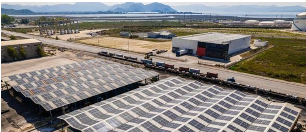
Druga sSunčana Elektrana – terminal za drvo od 803 kW – puštena u probni rad u prosincu 2025.
