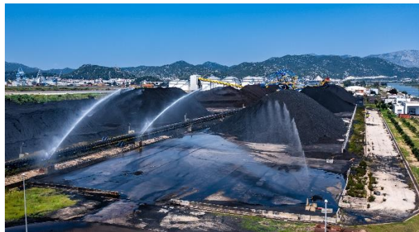
Na terminalu rasutih tereta ugrađen je sustav za prskanje koji se automatski aktivira, kako bi se spriječilo otpuštanje ugljene prašine.
