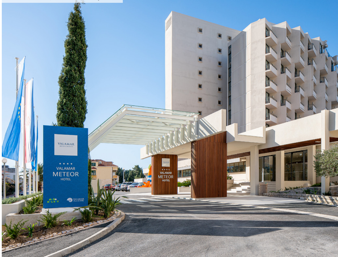
Valamar Meteor hotel, Makarska, novoobnovljeni ulaz
