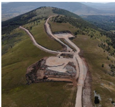
Izgradnja VE Mazin 2
