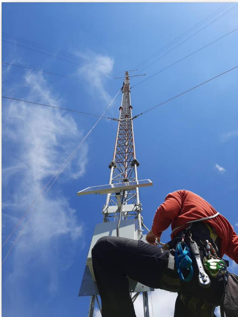
Mjerni stup za mjerenje vjetropotencijala
