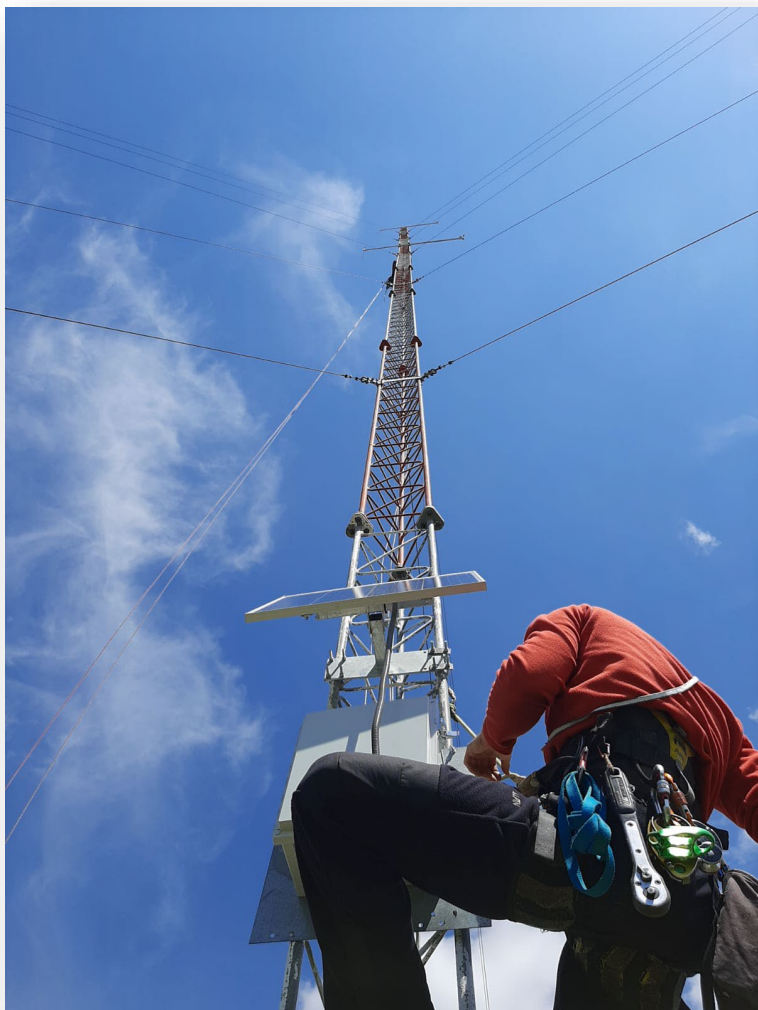
Mjerni stup za mjerenje vjetro potencijala
