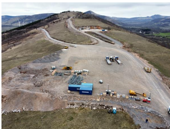
Lokacija izgradnje VE Mazin 2
