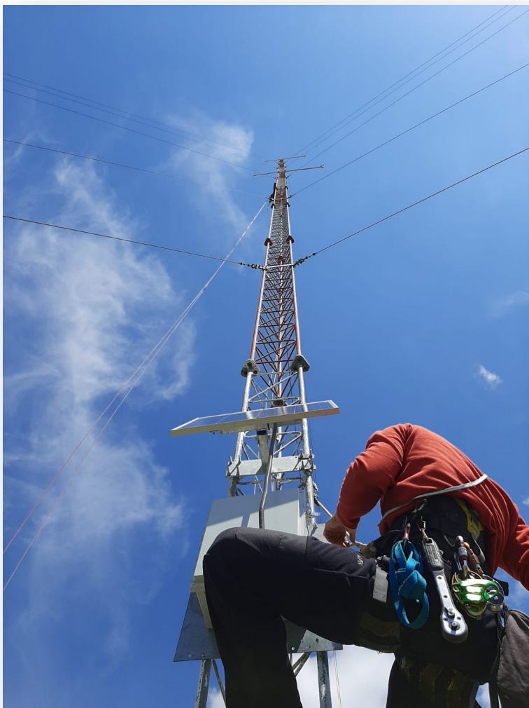
Mjerni stup za mjerenje vjetro potencijala
