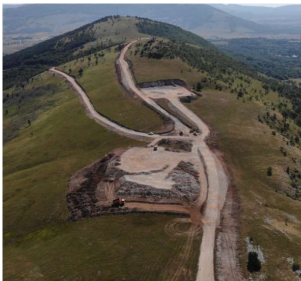
Lokacija izgradnje VE Mazin 2
